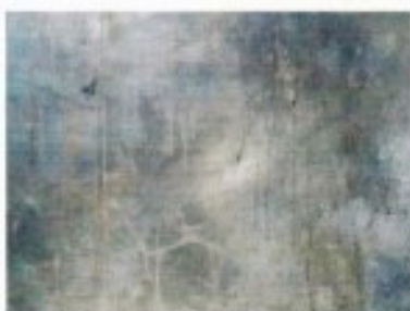
Détail de l'encrassement de la surface
